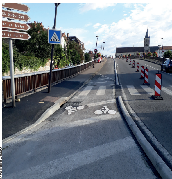
La piste à la fin des travaux au mois d'août.
