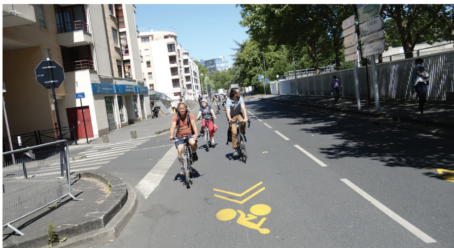
Aménagement d'une trajectoire centrale matérialisée dans la rue de Mazières à Evry-Courcouronnes (91). © Benoit Carrouée
