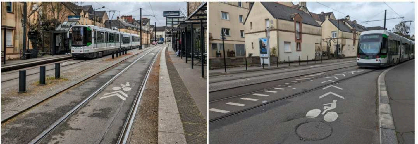
Exemple de chaussée de Tramway ouverte aux cycles comme ici à Nantes sur certaines portions
